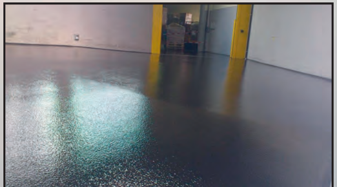
Mehrfarbige Einstreubeläge für Verkaufsflächen, Großküchen, Produktions- und Lagerflächen, je nach Nutzung erfolgt der Einsatz der Bindemittel auf Epoxidharz, Polyurethan- oder Meth-Acrylatbasis, einfarbige Strukturbeschichtung mit leicht zu reinigender Oberfläche für Rampen und Fahrwege
