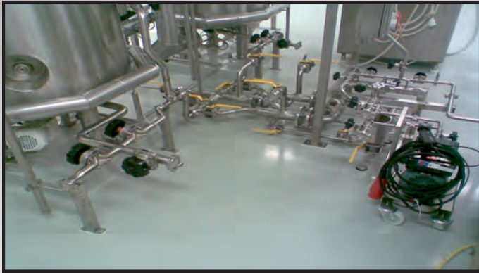
Labor- und Produktionsböden mit Reinraumanforderungen, glänzende und matte Oberflächen, ableitfähig, mehrfarbig, mit und ohne Einbauten, fachgerechten hochwertigen Hohlkehlen bis 12cm, chemisch hoch belastbar
