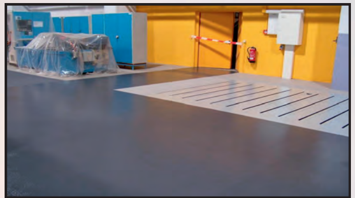
Stark geschädigter Betonboden mit Instandsetzung der Tragplatte und Glattbeschichtung auf Basis von lösemittelfreien Epoxidharz und zementgebundenen Beschichtungen, im Anschluss mit farbigem Wasserglas vergütet
