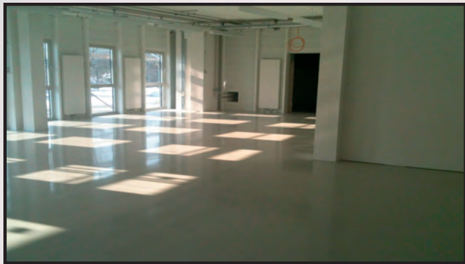
Epoxidharzbeschichtung als strapazierfähige, flexibel einsetzbare farbige Nutzflächen, hygienisch, emissionsarm als ESD- Böden mit zusätzlichen Schichtaufbauten, geprüfte Einstellung von Rutschhemmklassen von R9 bis R13
