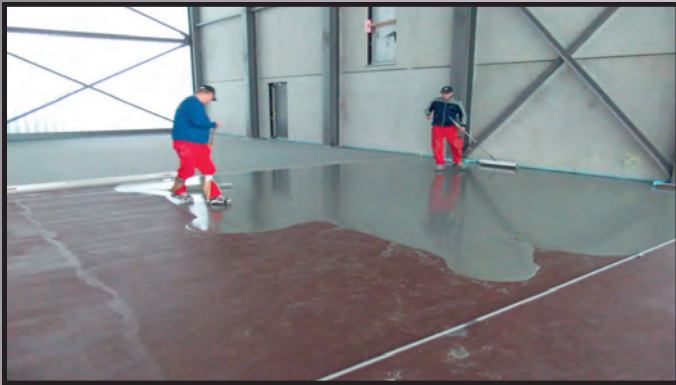
Hochregallagerböden gemäß DIN 15185, für hohe Rollbelastungen, antistatisch, fugenlos, diffusionsoffen
